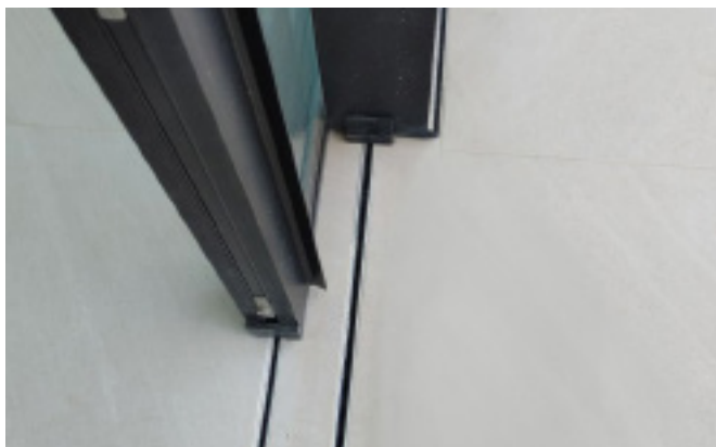
Metal Work / Carpintería Metálica
