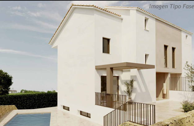
Fase 07 | Vivienda 10A
